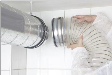
Abb. 9: Anschluss des Saugschlauches an das zu reinigende Rohr
