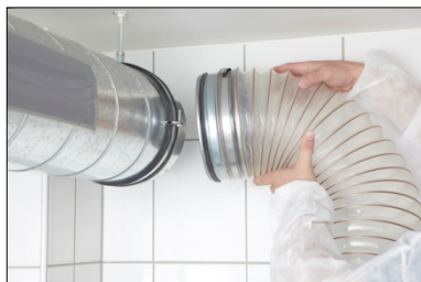
Afb. 33: Aansluiting van de zuigslang op de te reinigen buis
