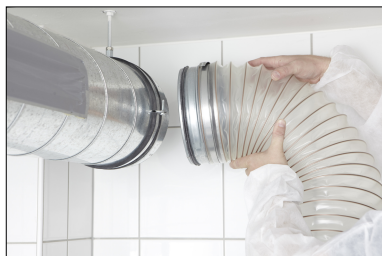
Image 9: Connecter le tuyau au tube à nettoyer
