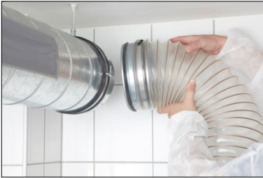
Fig. 21: Collegamento del tubo spiralato all'impianto da pulire
